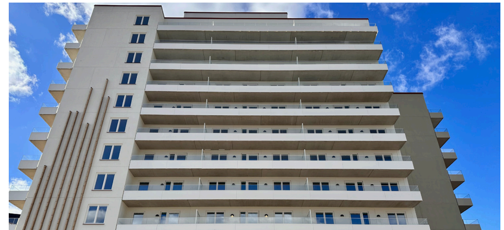
Solceller på taken, energieffektiv ventilation och värme från avloppsvatten.
