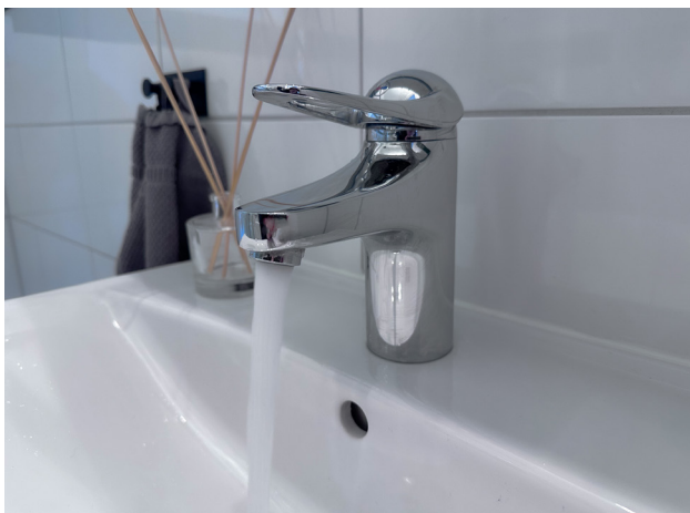
Vattenblandare som gör att kranen startar i kallvattenläge och stängs av på ett skonsamt sätt.
